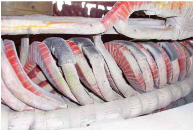
Wicklung eines Kraftwerksgenerators vor und nach der Reinigung mit Trockeneispellets
