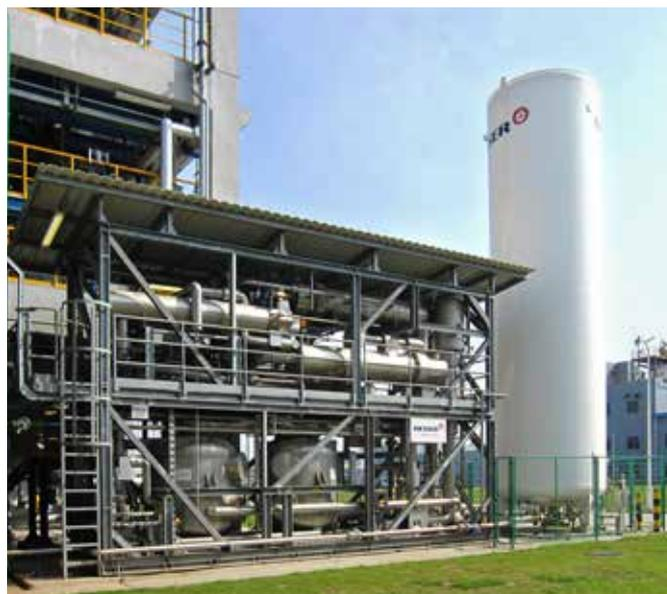
Anlage zur Methylchlorid-Rückgewinnung mit flüssigem Stickstoff
